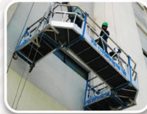
U ပုံသဏ္ဍာန် အမြင့်တက် စက်ဆွဲ ကြိုးဆိုင်းပုခက်
